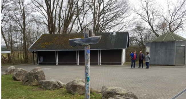
Küche und Geräteraum und Toilette rechts
